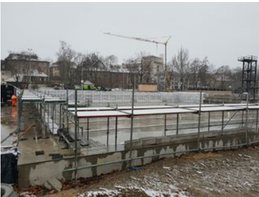
☞ Blick auf die Bauarbeiten am Freischwimmbekken des Schwanseebades (Foto: Stadt Weimar)
