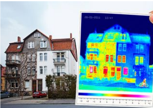
☞ Eine Thermografieaufnahme stellt in roten Farben dar, wo ein Haus Wärme verliert. Foto: Deutsche Bundesstiftung Umwelt
