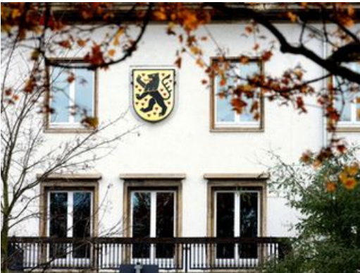
Fassade der Stadtverwaltungsgebäude in der Schwanseestraße (Foto: Stadt Weimar)
