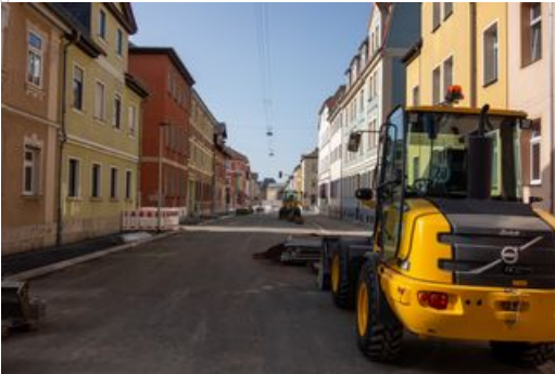
▮ Bauarbeiten in der Carl-von-Ossietsky-Straße zwischen Friedrich-Ebert-Straße und Friesstraße.
