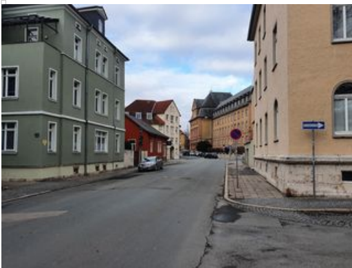
▢ Bauabschnitt zwischen Buchenwaldplatz und Ernst-Thälmann-Straße.
