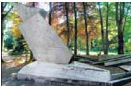
Das Denkmal der Märzgefallenen von Walter Gropius (1920) auf dem Weimarer Hauptfriedhof
