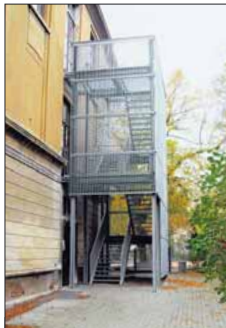
Stahltreppe an der Falk-Grundschule
