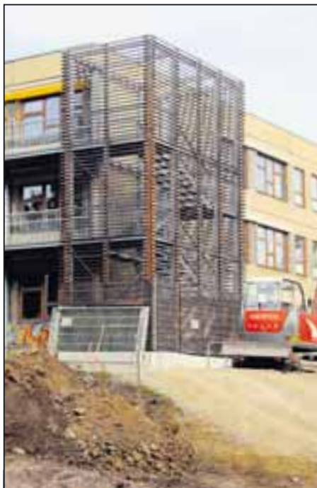
Fluchttreppe am Humboldt-Gymnasium
