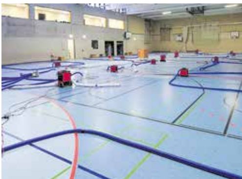
Sporthalle während der Trocknung des Bodens
