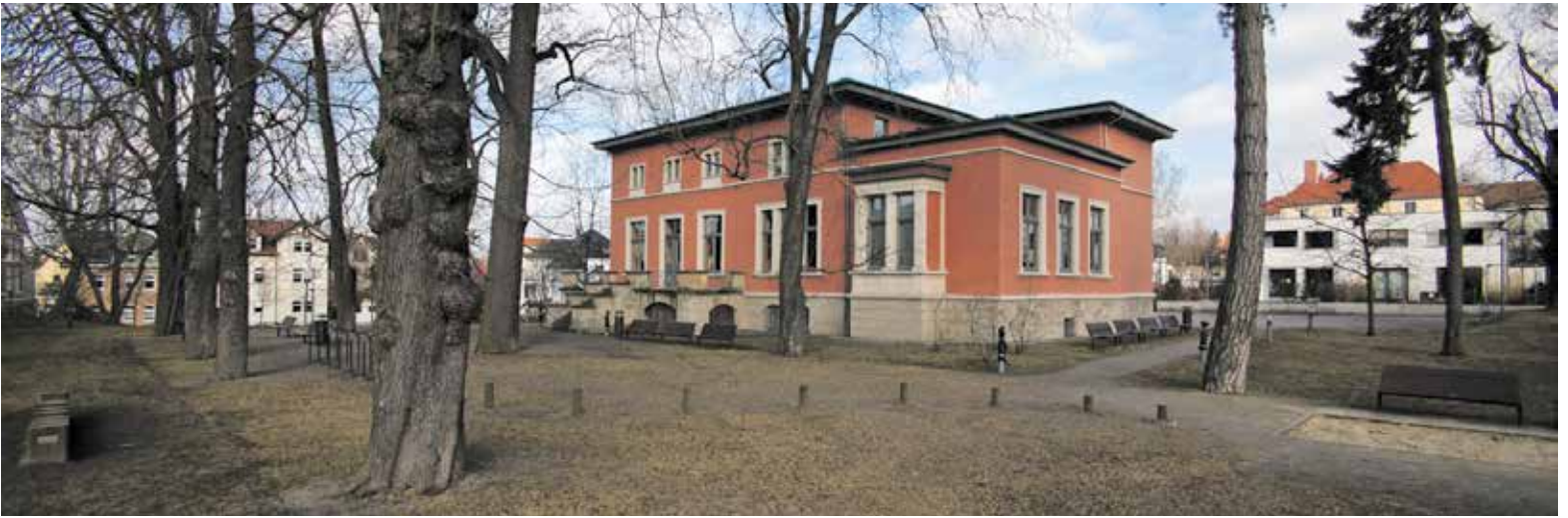
Das Gebäude in einem Kastanienwäldchen in der Albrecht-Dürer-Straße 2 beherbergt seit 1999 Bereiche der Bauhaus-Universität Weimar. Es wurde 1896 fertiggestellt und war ursprünglich ein Offizierskasino der benachbarten Streichhan-Kaserne. Foto: Bauhaus-Universität Weimar, Jens Hauspurg
