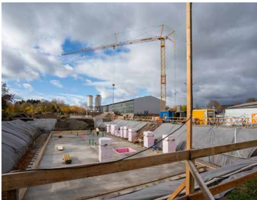
Aktuelle Großbaustelle in der Schwannseestraße – der Neubau des Betriebshof des Kommunalerservice Weimar (Bild oben).
