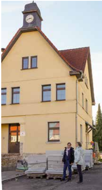
Die Leiterin des Amtes für Gebäudewirtschaft, Angela Braunmiller und Kollegin Angela Gonsior vor der Baustelle am Bürger- und Vereinshaus in Legefild. Foto: Michael Zapfe
