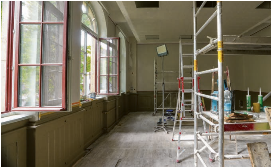
Elektroinstallation, Einbau von Akustikdecken und neuen Fenstern, Fußboden- und Malerarbeiten: Im Goethegymnasium werden beste Lernbedingungen geschaffen. Foto: Michael Zapfe
