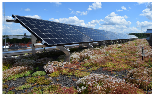
Extensive Dachbegrünung mit PV-Modulen (Quelle: Bundesverband Gebäudegrün)
