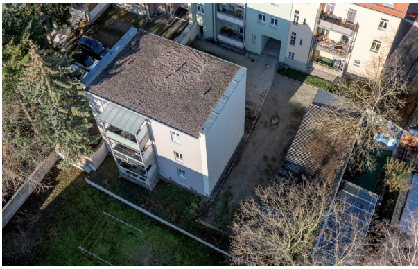
Innenhof in der Meyerstraße 41/41a (Quelle: Weimarer Wohnstätte)
