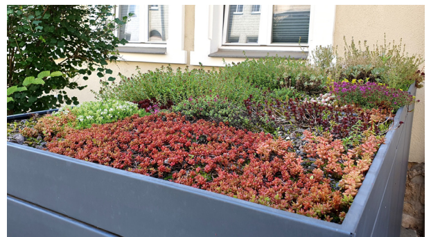
Extensive Dachbegrünung speichert Regenwasser auf einer Mülleinhausung
