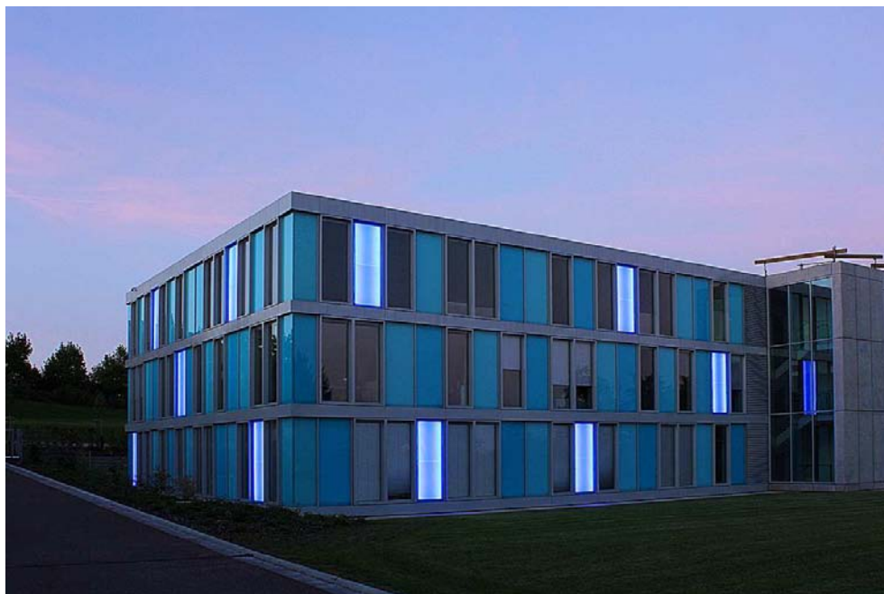
Nordstraße, Gewerbeneubau der Firma Glatt Ingenieurtechnik
